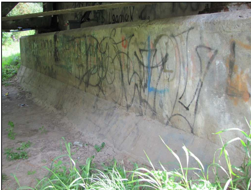
Zdj.21 Przyczółek prawobrzeżny - widoczne zanieczyszczenia w postaci graffiti, lokalne ubytki betonu.
