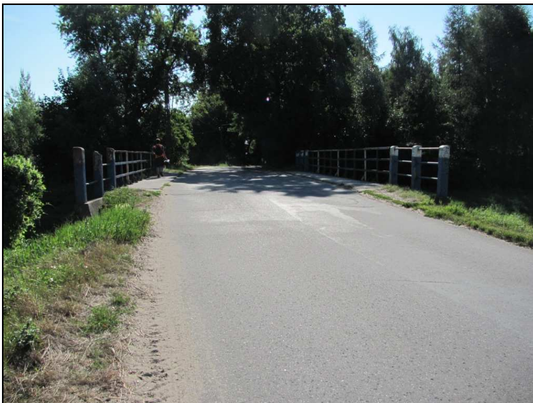
Zdj.1 Widok ogólny na część przejazdową od strony centrum Jadowa.
